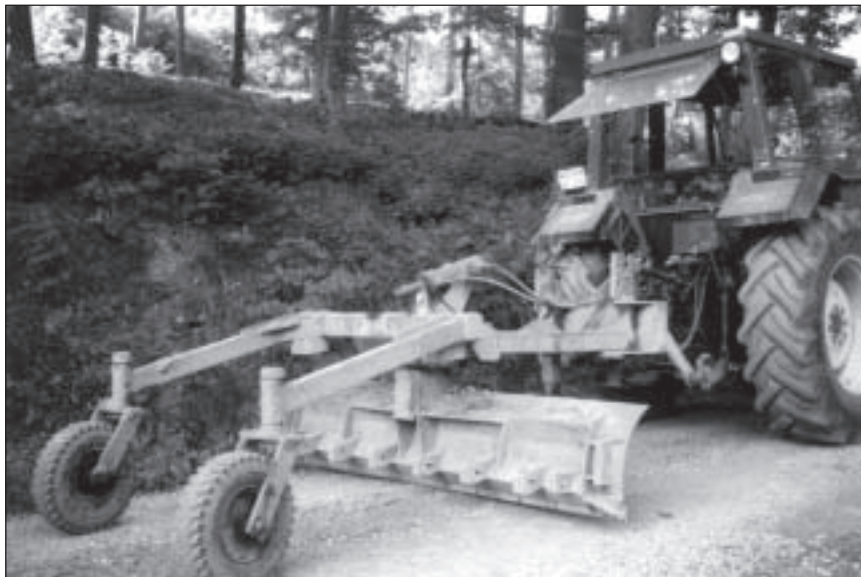
Laufende Profilerhaltung mit dem Anbau-Wegehobel
