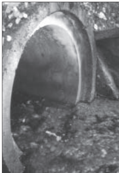
Rohrdurchlass, ausreichend belichtet mit natürlicher Sohle durch Verlandung
