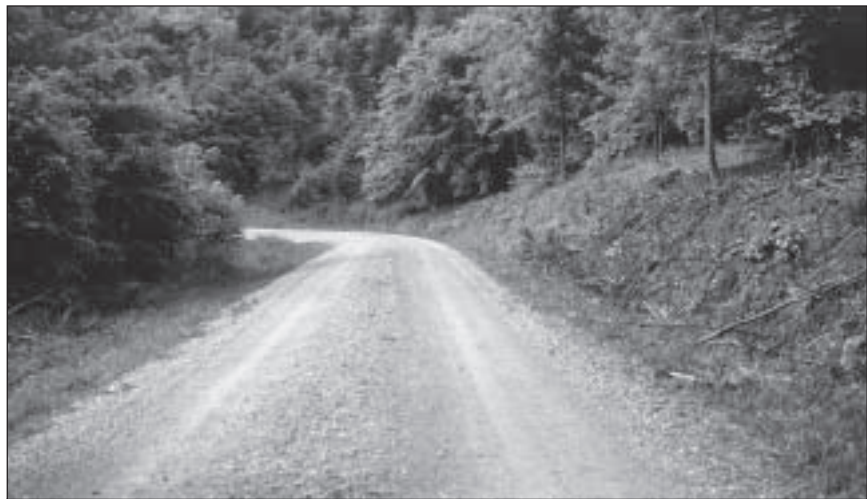
Fahrweg mit beidseitig geneigtem „Uhrglasprofil“
