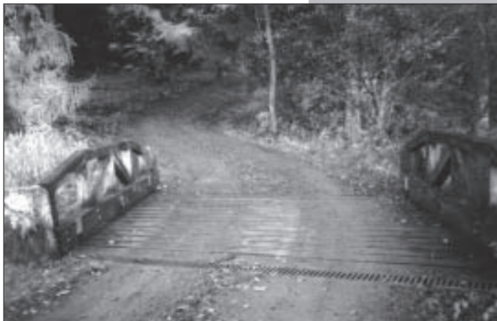
Holzbrücke, Fahrbahn aus Eichenbohlen auf Eichenträgern
