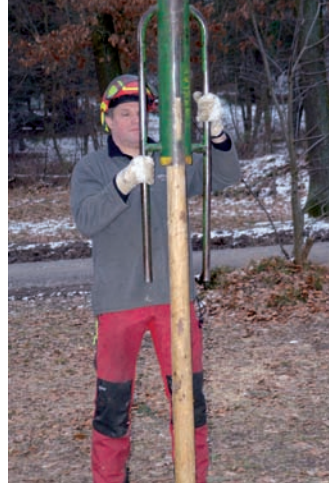
Mit einer Rammkatze lassen sich Zaunpfähle von Hand oder mit Hilfe eines starken Hammers einrammen.
