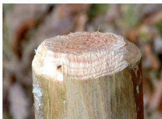
Oben: Die Schlagplatte von Zaunpfählen sollte eine Fase haben, um das Holz beim Einrammen nicht sofort aufzusplintern.
