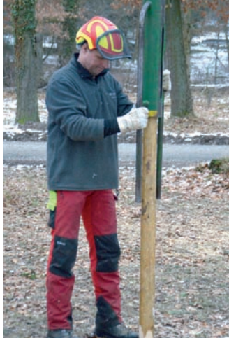
Mit einer Rammkatze lassen sich Zaunpfähle von Hand oder mit Hilfe eines starken Hammers einrammen.
