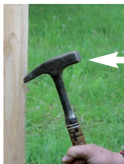
Oben links: Der Einschnitt einer Platte als Auflagefläche. Oben mitte und rechts: Auf dem eingeschlagenen Latthammer wird die Strebe abgelegt, befestigt und anschließend abgelängt (unten).
