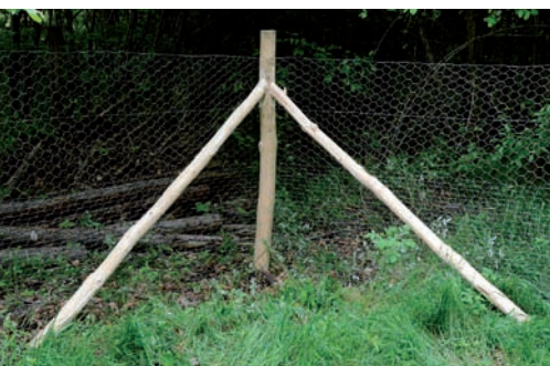
Oben: Die Abstrebung sollte länger als die Pfosten sein. Unten: Zum Schutz vor Nässe werden die Streben am Nachbarpfosten „höhergelegt“.
