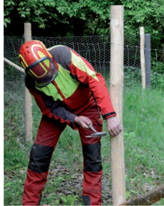
Oben: Mindestens drei Befestigungspunkte je Pfosten – oben, unten und mittig – benötigt ein stabiler Drahtzaun. Unten: Fertige Ecke von innen.
