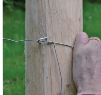
Oben und unten: Die Krampen werden schräg in verschiedene Faserverläufe eingeschlagen, um dauerhafter zu halten. Fotos: Bernd Heinrich, KWF
