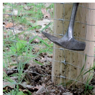
Oben und unten: Die Krampen werden schräg in verschiedene Faserverläufe eingeschlagen, um dauerhafter zu halten. Fotos: Bernd Heinrich, KWF
