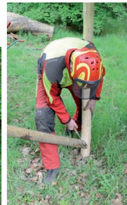
Unten und rechts: Die Streben werden erst oben, dann unten angegelt.
