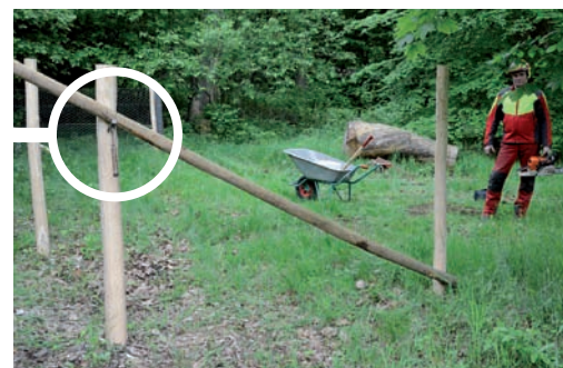
Unten und rechts: Die Streben werden erst oben, dann unten angegelt.
