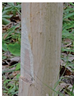
Oben links: Der Einschnitt einer Platte als Auflagefläche. Oben mitte und rechts: Auf dem eingeschlagenen Latthammer wird die Strebe abgelegt, befestigt und anschließend abgelängt (unten).
