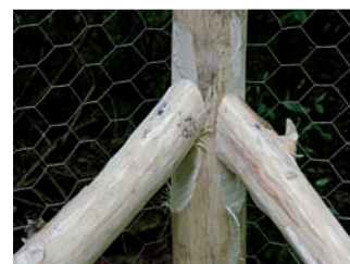
Oben: Mindestens drei Befestigungspunkte je Pfosten – oben, unten und mittig – benötigt ein stabiler Drahtzaun. Unten: Fertige Ecke von innen.
