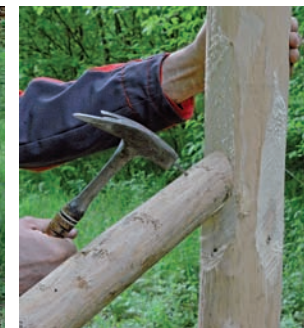
Unten und rechts: Die Streben werden erst oben, dann unten angegelt.
