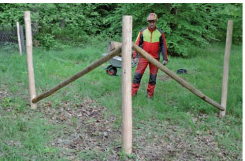
Oben: Die Abstrebung sollte länger als die Pfosten sein. Unten: Zum Schutz vor Nässe werden die Streben am Nachbarpfosten „höhergelegt“.
